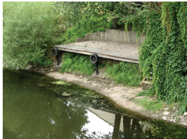
Das permanent geöffnete Rothenförder Wehr
